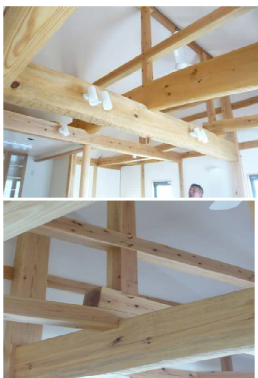
図4-3 組合員の手 けた伝統工法住宅（船橋市内）
